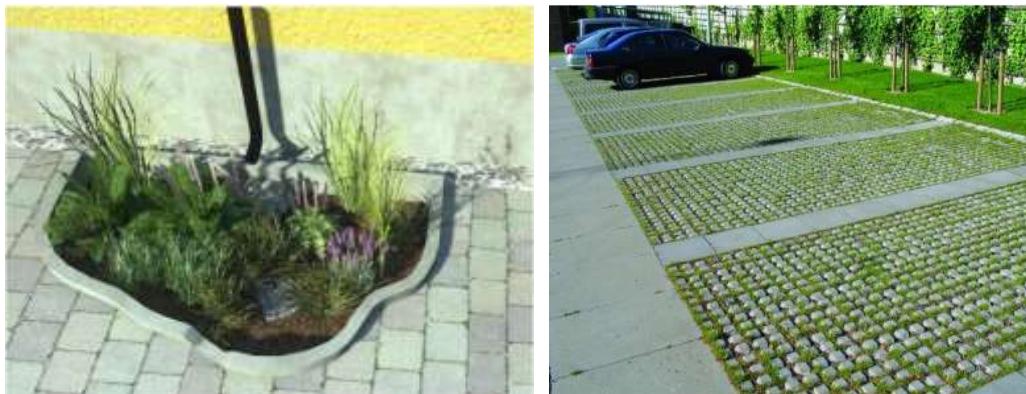
Bilderna är hämtade ur Anvisningar och principlösningar för dagvattenhantering på kvartersmark och allmän plats (Nacka kommun, 2018) och ger förslag på olika sätt att arbeta med genomsläppliga material och rening av dagvatten.
