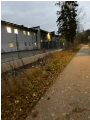
Avsaknad av skyddsplanteringar, bygglovenhetens tillsynsbesök den 8 december 2020.
