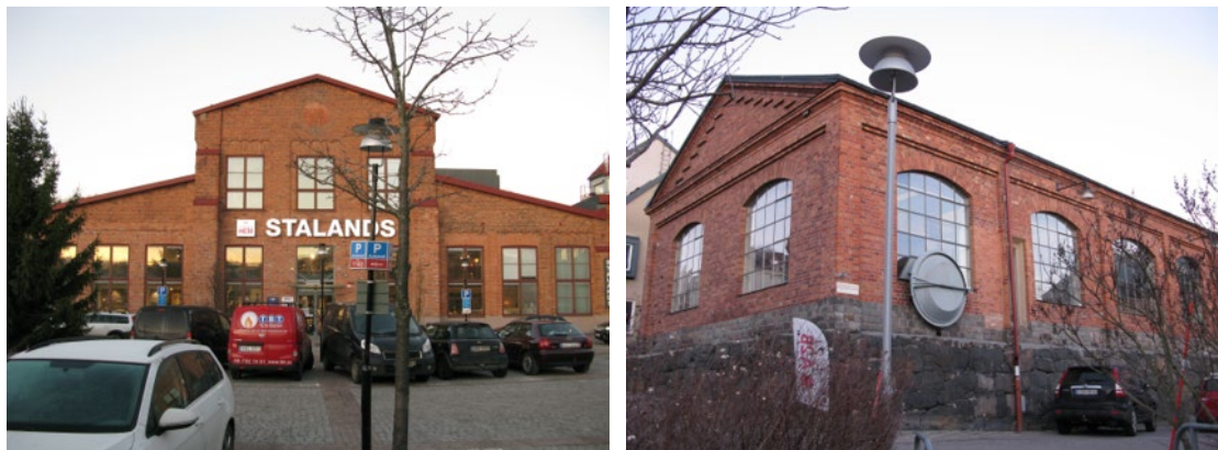
Bilderna visar industribyggnader som saknar skyddsbestämmelser i gällande plan (till vänster, det så kallade Gjuteriet och till höger det så kallade Pumphuset).
