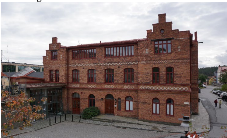
Ritningskontorets fasad mot norr.
