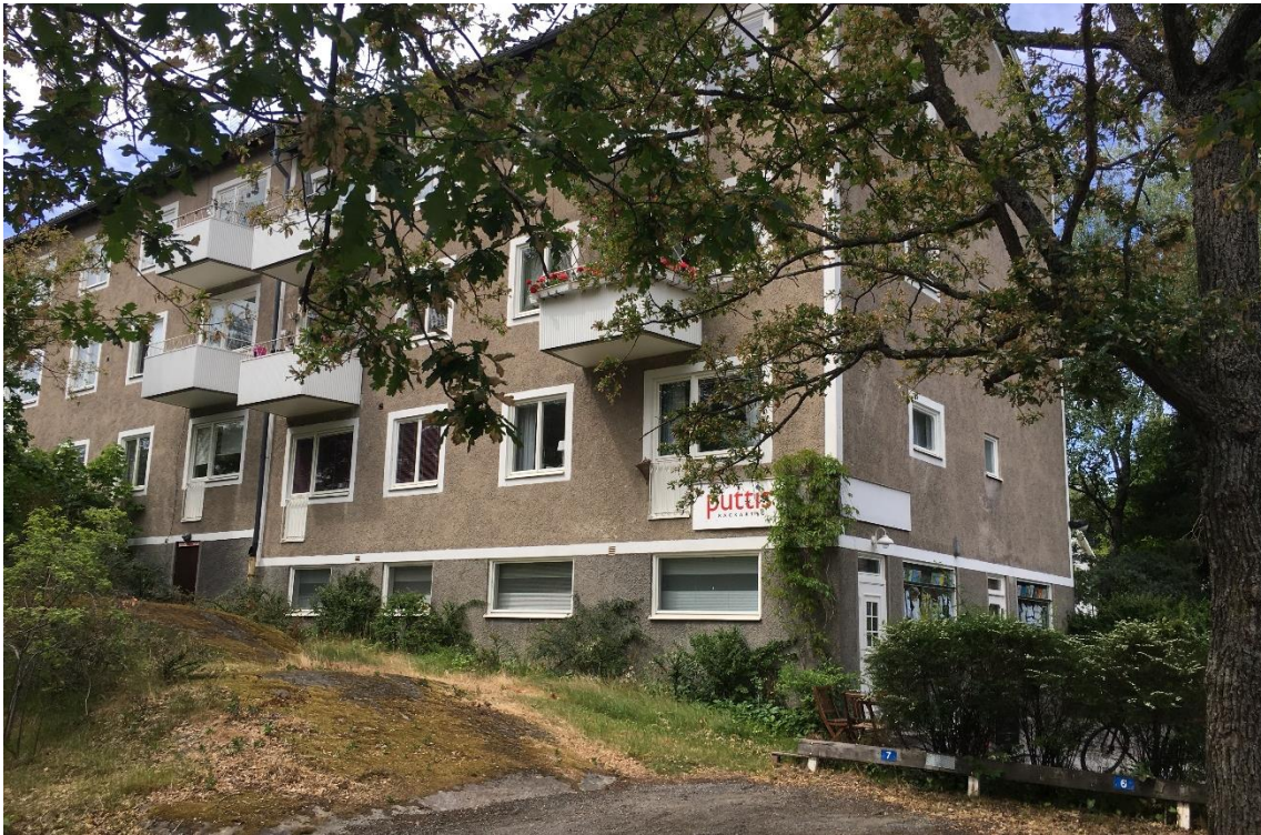
Figur 6. Flerbostadshuset på fastigheten Björknäs 1:239 byggt 1949. Notera fasaddetaljerna i vit slätputs. Foto: Viktor Wallström
