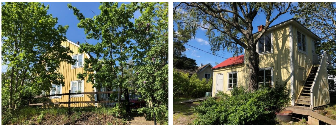
Figur 2 och 3. Den gula 1920-talsvillan på fastigheten Björknäs 1:376 och tillhörande komplementbyggnad i två våningar som föreslås rivas.
