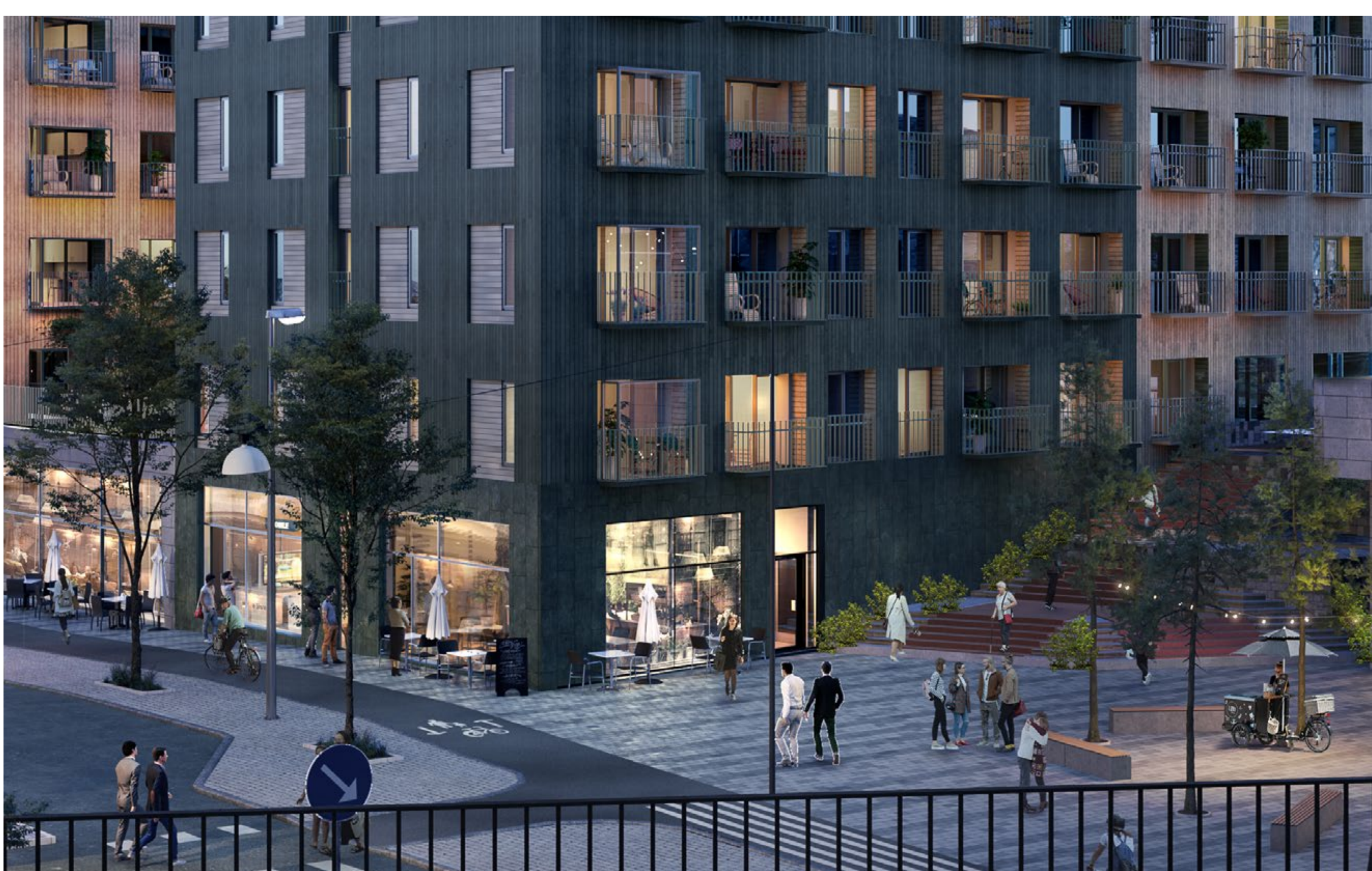
Levande urban miljö mot Värmdövägen
