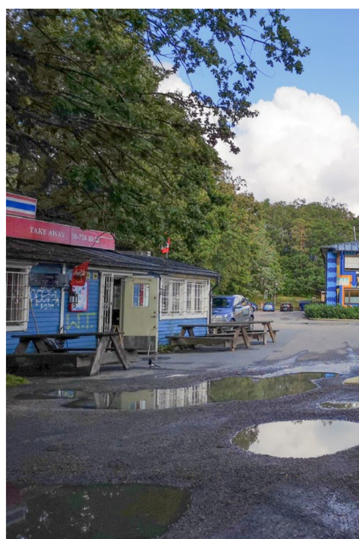
Matkiosk, fastigheten Sicklaön 361:1
