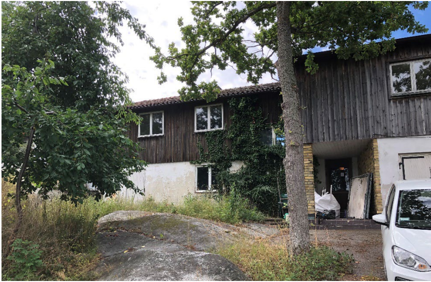
Figur 4: Huvudbyggnaden på Solsidan 55:10 är uppförd i souterräng med två våningar mot gatan och en våning mot vattnet. Souterrängsvåningen rymmer bland annat huvudentré och garage.
