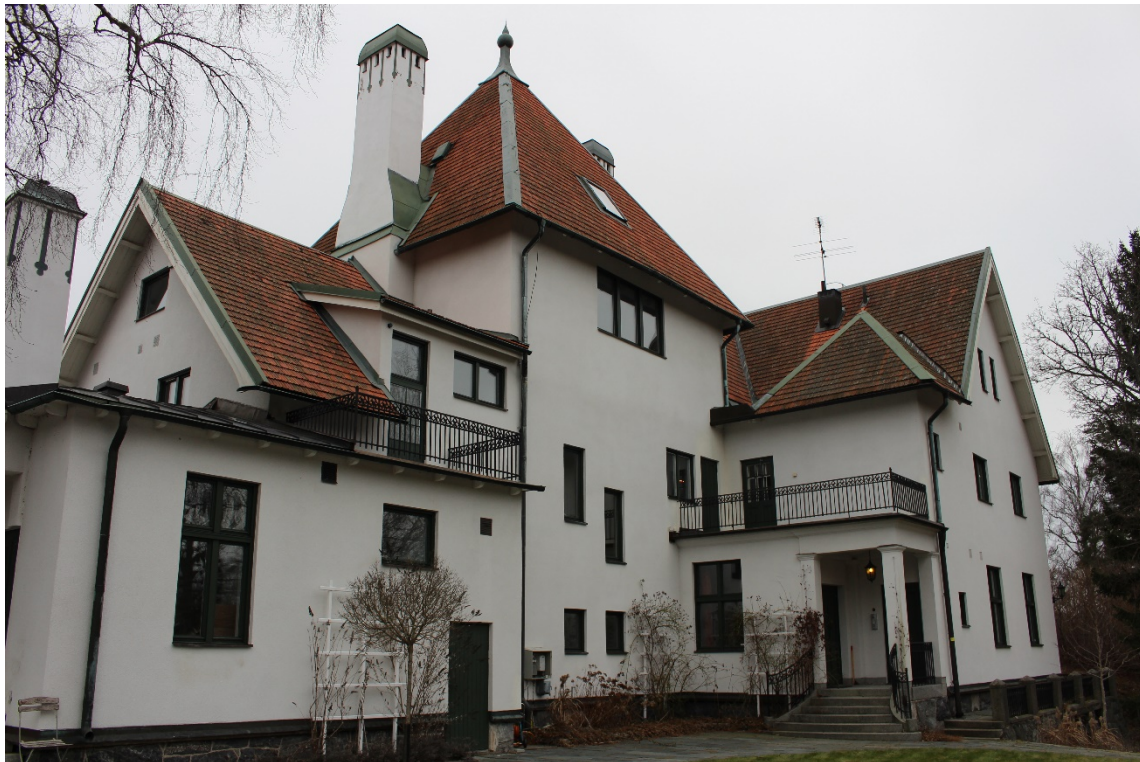
Huvudbyggnaden med fasad mot Svartviksringen i sydväst. Byggnaden har en varierande takutformning med två gavelpartier och en torndel. Bild: Tyréns 2017.
