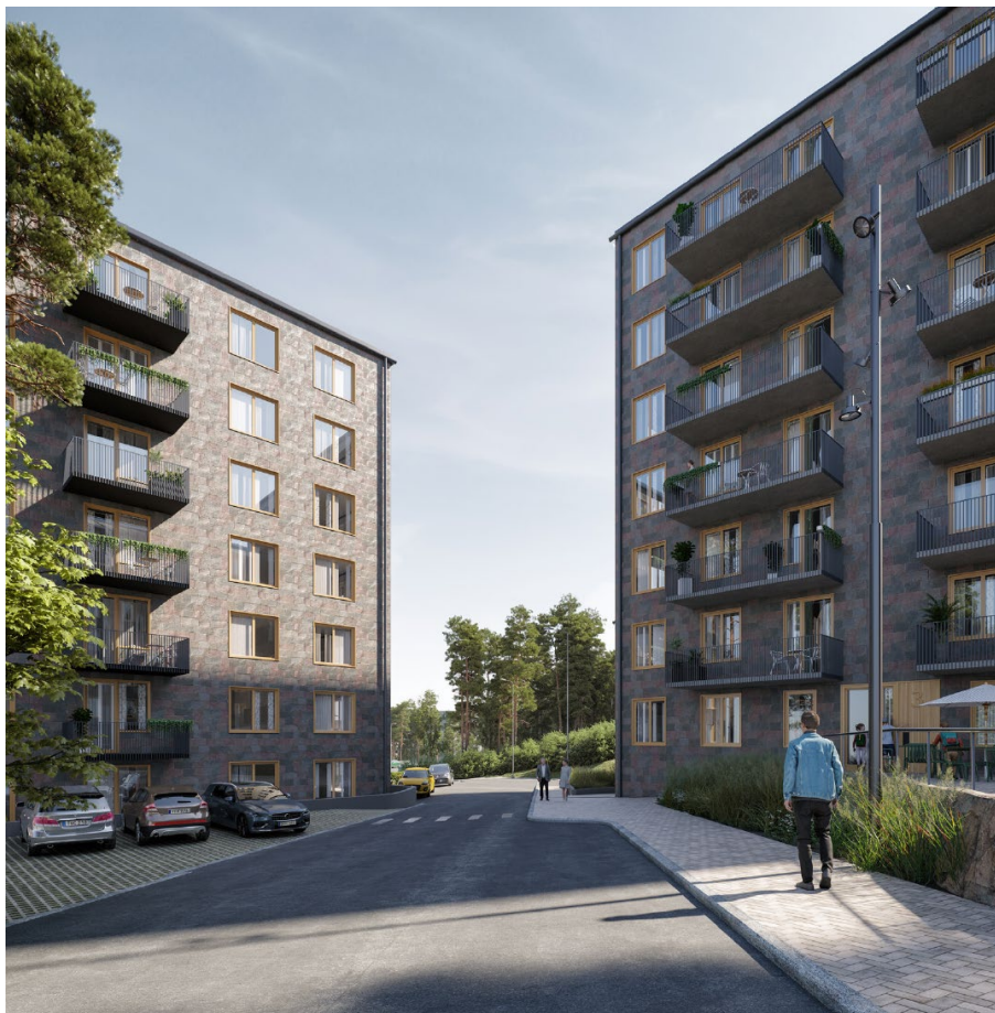
Perspektiv över möjlig utformning av bebyggelsen sett från den föreslagna lokalgatan. Vy mot sydöst. Takföthöjd, maximal takvinkel, fönstersättning i vertikala band, fasadmaterial och accentfärger styrs av plankartan. Illustration: Arkitema
