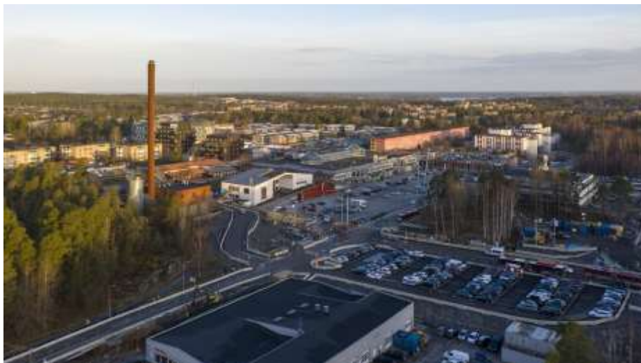
Bild 2. Flygbild över Orminge C. Stora delar av centrum är under ombyggnad och utbyggnad för att möjliggöra fler bostäder och arbetsplatser. Kameran är riktad åt planområdet Pylonens håll som ligger bortom några av punkthusen som anas i grönskan bakom det långa röda huset. Foto Henrik Trygg, 2019.
