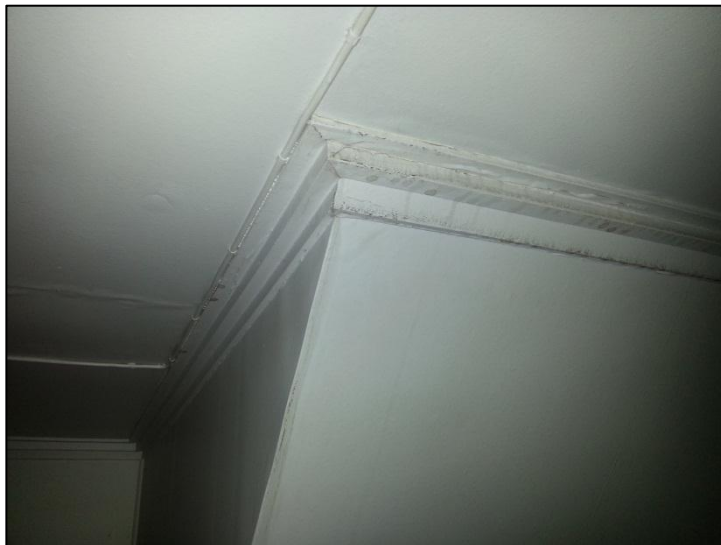
Äldre profilerad taklist rum 210 Foto: Jonas Sundwall, Tyréns AB
