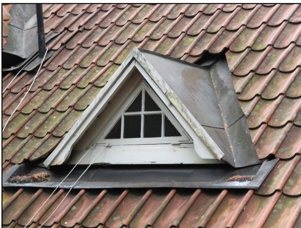
Mindre takkupa på byggnadens nordöstra sida Foto: F. Mellander Rönn. Tyréns AB
