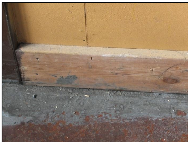
Troligen ursprungligt linoleumgolv och äldre golvsockel rum 104. Foto: Fredrika Mellander Rönn, Tyréns AB
