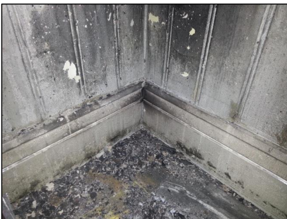
Pärlspont och profilerad golvsockel i rum 201 Foto: Jonas Sundwall, Tyréns AB
