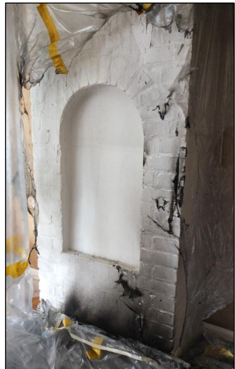
Murstock med kaminnisch rum 101 Foto: F. Mellander Rönn, Tyréns AB
