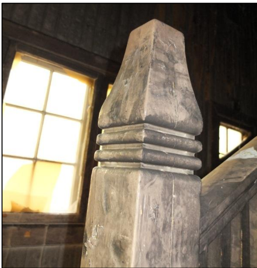
Profilerad trappstolpe Foto: F. Mellander Rönn, Tyréns AB
