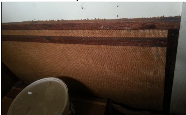
Bröstning med grov väv rum 211 Foto: Jonas Sundwall, Tyréns AB
