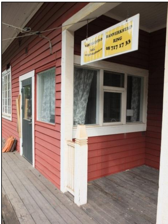
Sydvästra fasaden med fönster in mot f.d. Stins expeditionen på den indragna verandan Foto: F. Mellander Rönn, Tyréns AB
