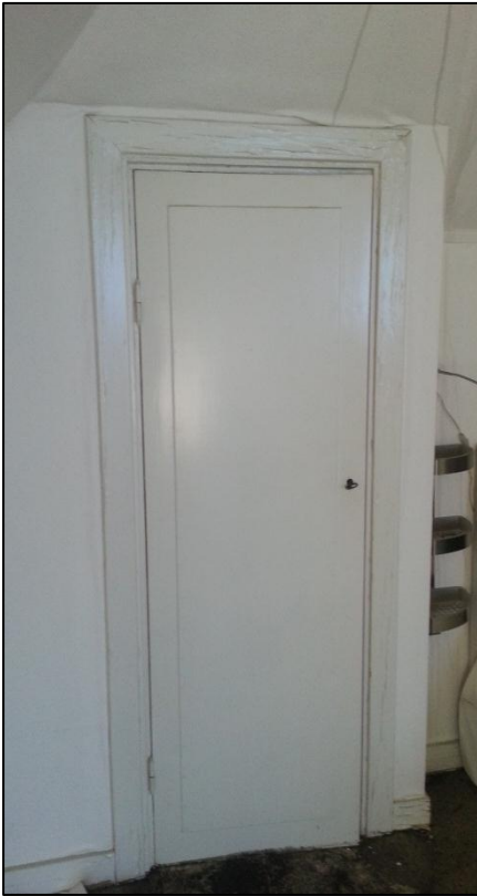
Dörr till kattvind i rum 206 Foto: Jonas Sundwall, Tyréns AB
