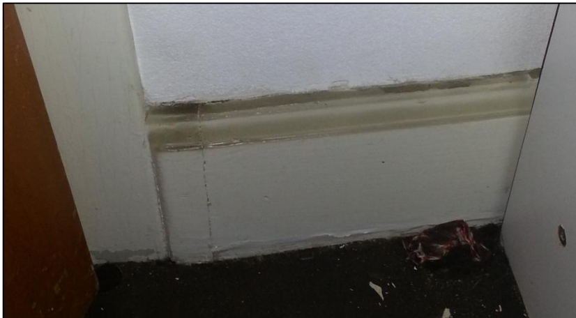
Äldre profilerad golvsockel i rum 209 Foto: Jonas Sundwall, Tyréns AB
