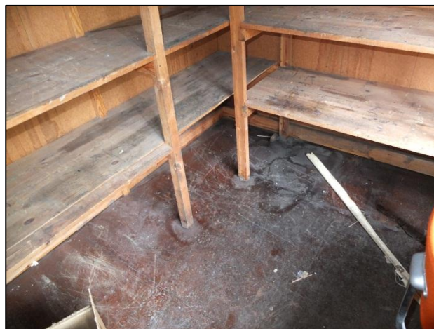
Fasta hyllor och troligen ursprungligt linoleumgolv rum 104. Foto: Fredrika Mellander Rönn, Tyréns AB.
