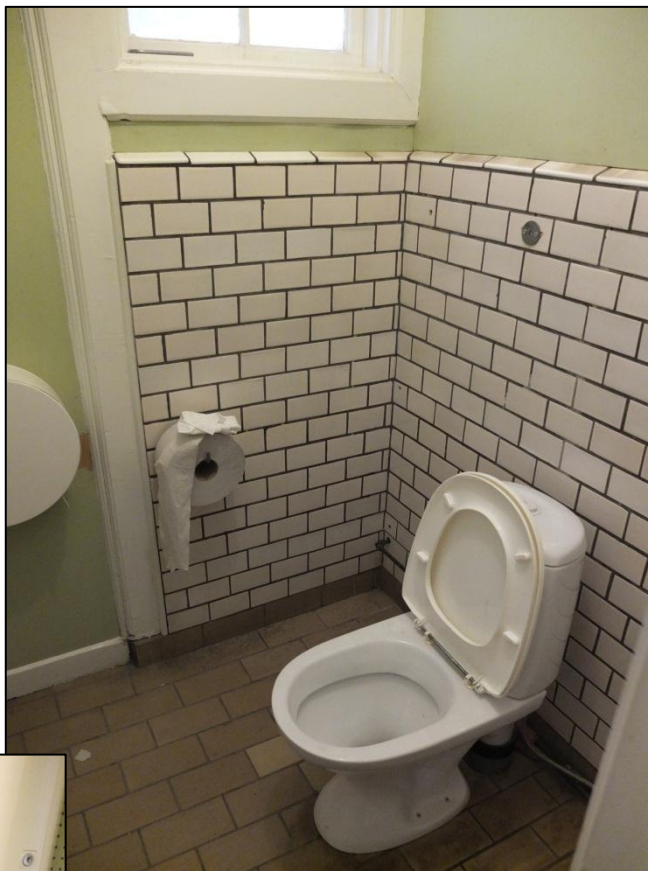
Rum 110 med gult klinkergolv och kaklad vägg Foto: F. Mellander Rönn, Tyréns AB
