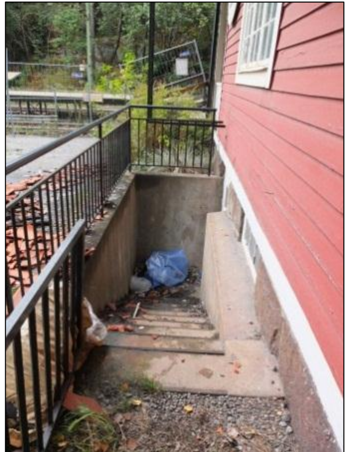
Källartrappa med svart räcke. Foto: F. Mellander Rönn, Tyréns AB
