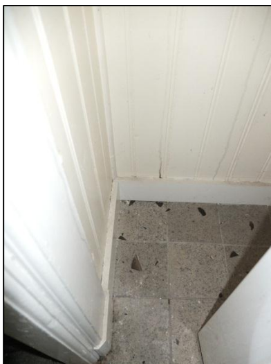
Pärlspont, dörrfoder, golvsockel och klinkergolv i rum 109
