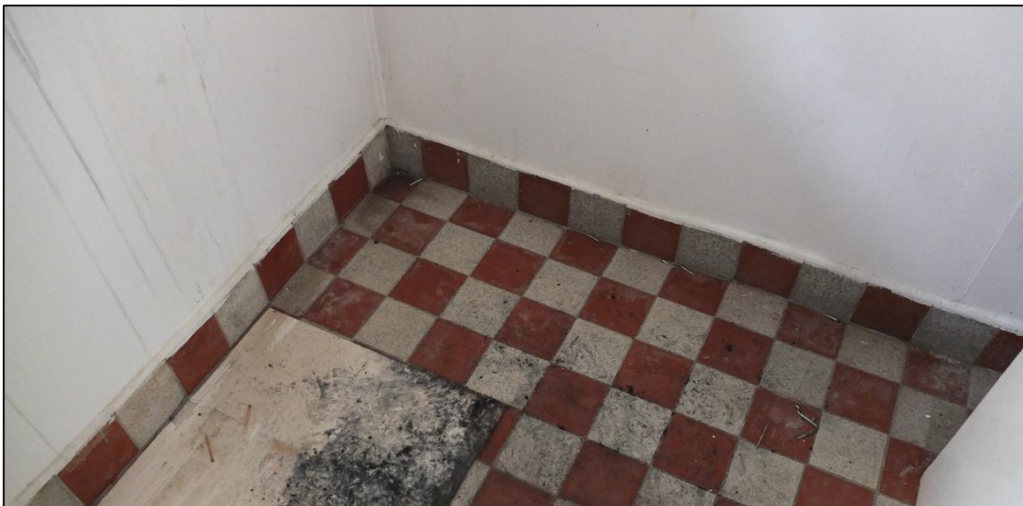
Klinkergolv rum 102. Foto: Fredrika Mellander Rönn, Tyréns AB
