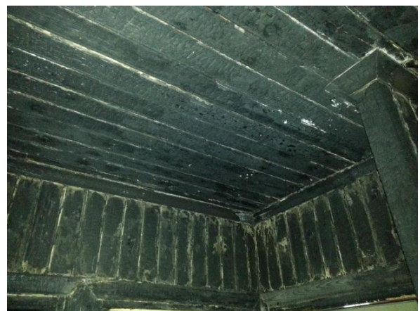
Brandskadad pärlspontpanel på vägg och i tak i övre hall, rum 201. Foto: Jonas Sundwall, Tyréns AB
