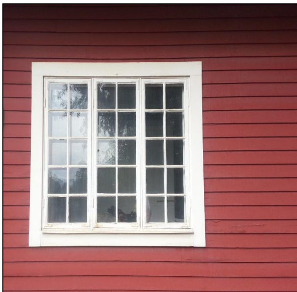
Ursprungligt fönster på byggnadens sydöstra gavelfasad Foto: Jonas Sundwall, Tyréns AB
