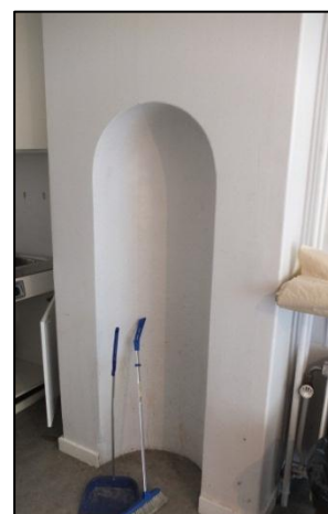
Murstock med kaminnisch rum 103. Foto: F. Mellander Rönn, Tyréns AB
