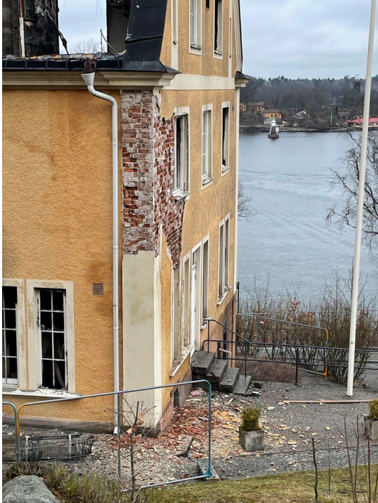
T.v. Bild 20. T.h. Bild 21. Fasad mot öster. Puts har fallit ner kring hörnan och in mot ett fönster och exponerat underliggande tegel.
