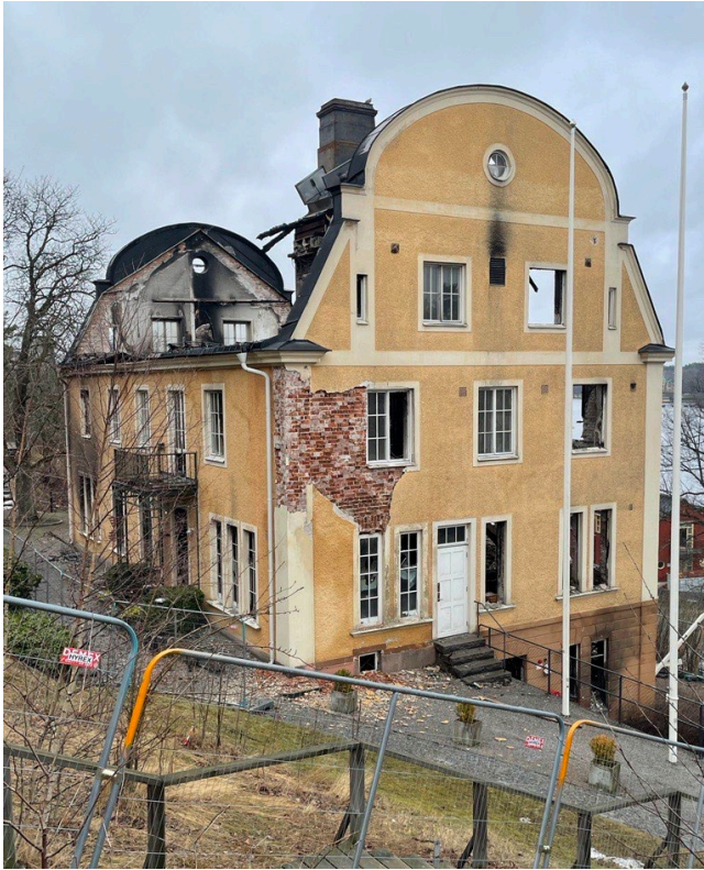
Bild 19. Fasad mot öster. Putsen är delvis skadad och har fallit ner. Flera fönster, bl.a. ett runt fönster i gaveln har klarat sig.
