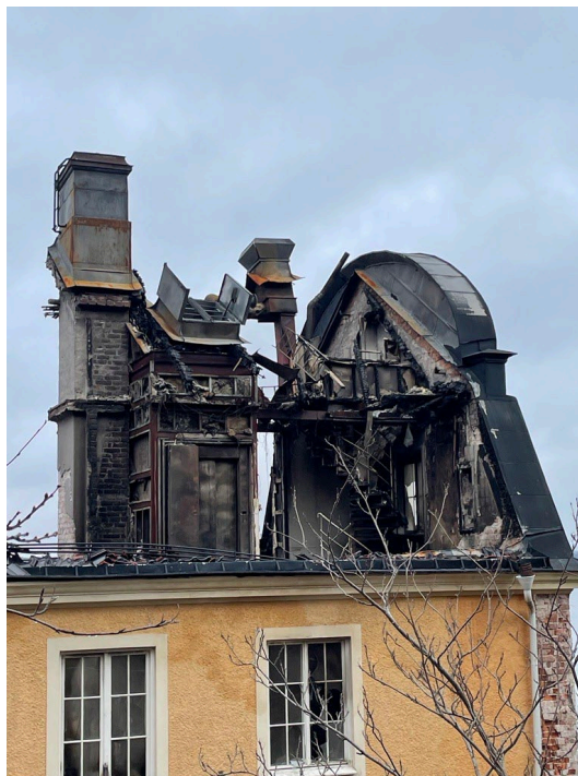
T.h. Bild 18. Fasad mot söder. Foto av intakt plåtskoning på gaveln samt murstock.
