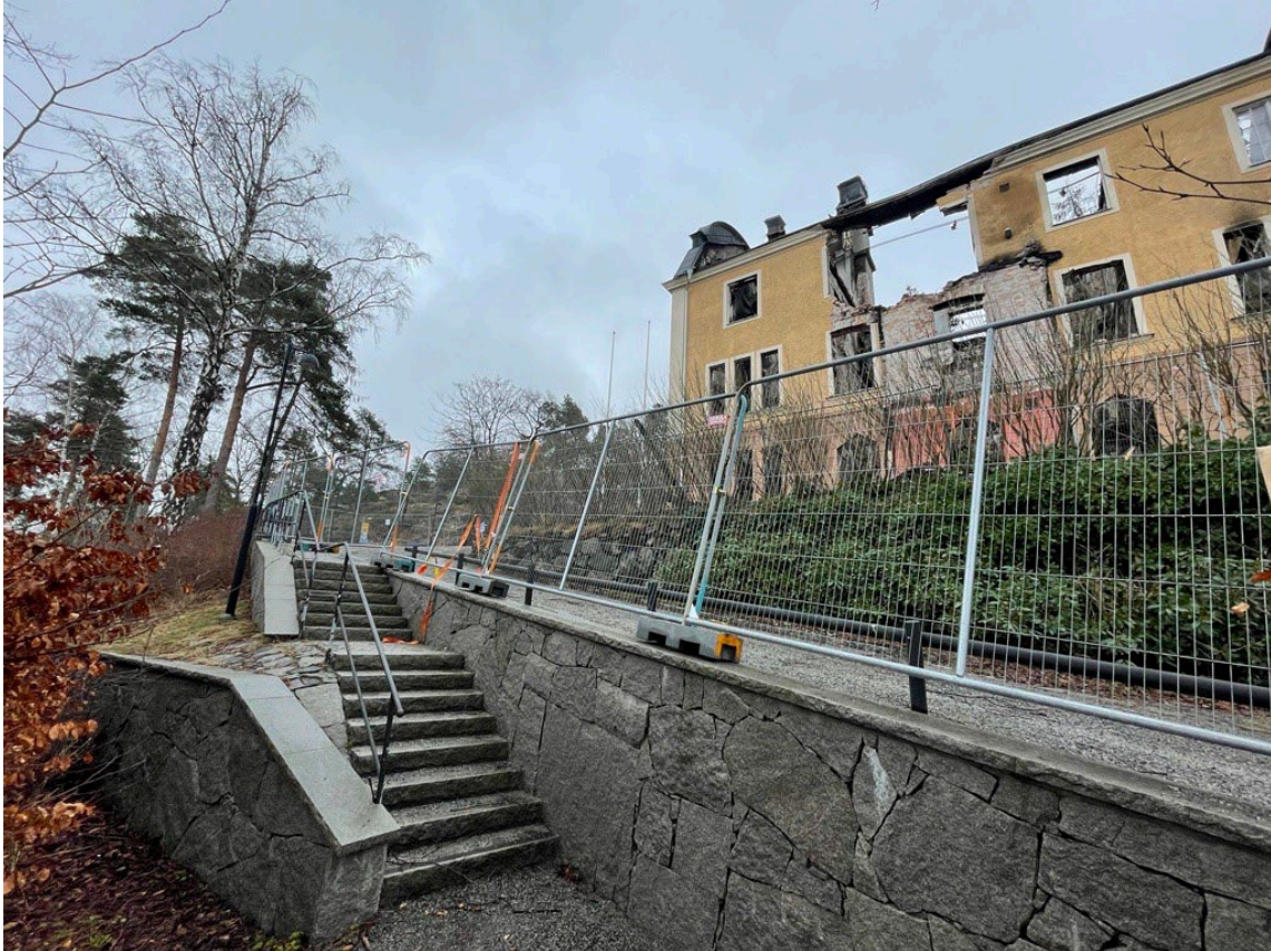
Bild 7. Vägen närmast byggnaden var avspärrad med byggstängsel. Byggnaden gick därmed inte att komma nära från den långa trappan som leder upp från Augustendalsvägen.
