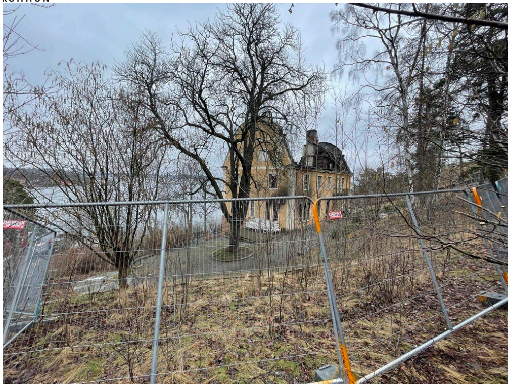
Bild 5. Fabrikörsvillan sett från naturmarken i söder med farleden i bakgrunden. Området kring villan är inhägnat med byggstängsel.
