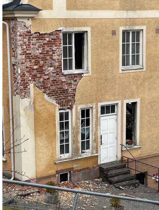
T.v. Bild 20. T.h. Bild 21. Fasad mot öster. Puts har fallit ner kring hörnan och in mot ett fönster och exponerat underliggande tegel.
