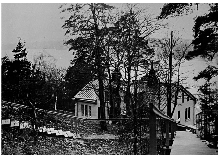
Ovan: Sommarvillan på Augustendal som uppfördes på 1870-talet. Notera hur första våningens fönsteröppningar överensstämmer med samma våning efter ombyggnaden 1916. Nedan huset fotograferat från trapporna som ledde upp till fabriksområdet. Bilder från Nacka Lokalhistoriska arkiv.
