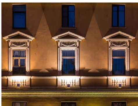
Fasaden är belyst med ett hårt ljus underifrån, vilket ger skarpa skuggor som gör fasaden rörig.
