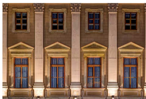
Den här fasaden är också belyst underifrån, men på ett mer balanserat sätt jämfört med den översta bilden. Ljuset är inte lika hårt. Det uppåtriktade ljuset är kompletterat med ljus framifrån.
