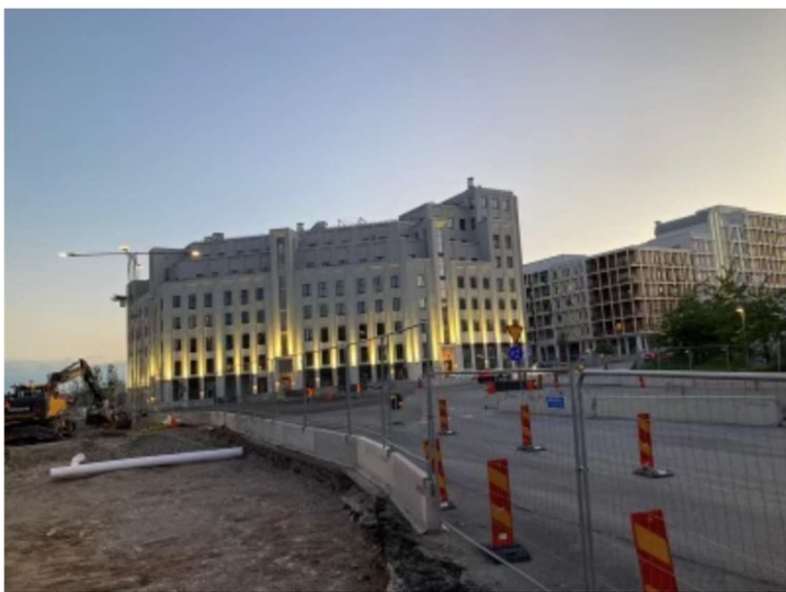
Verklig bild på fasaden
