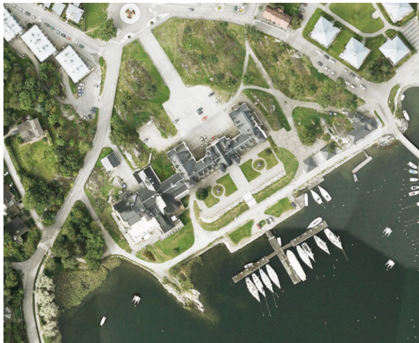
Bild 10. Översiktsbild som visar hotellet som det ser ut idag med en hårdgjord yta för parkeringar framför hotellet. Källa: Arcona
