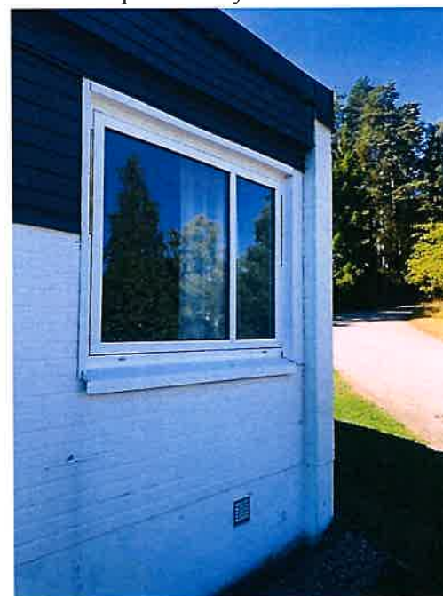
Pivåhängt PVC-fönster från 1980-talet
