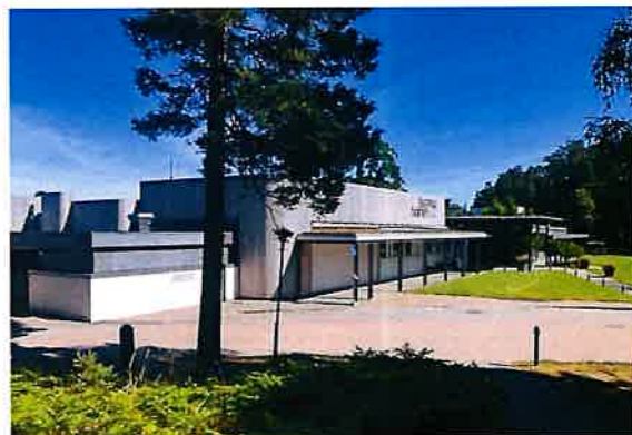
Huvudbyggnadens sydfasad med entrén till Skepparholmen
