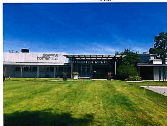
Sydsidan med träskärm och entrétak från 2019
