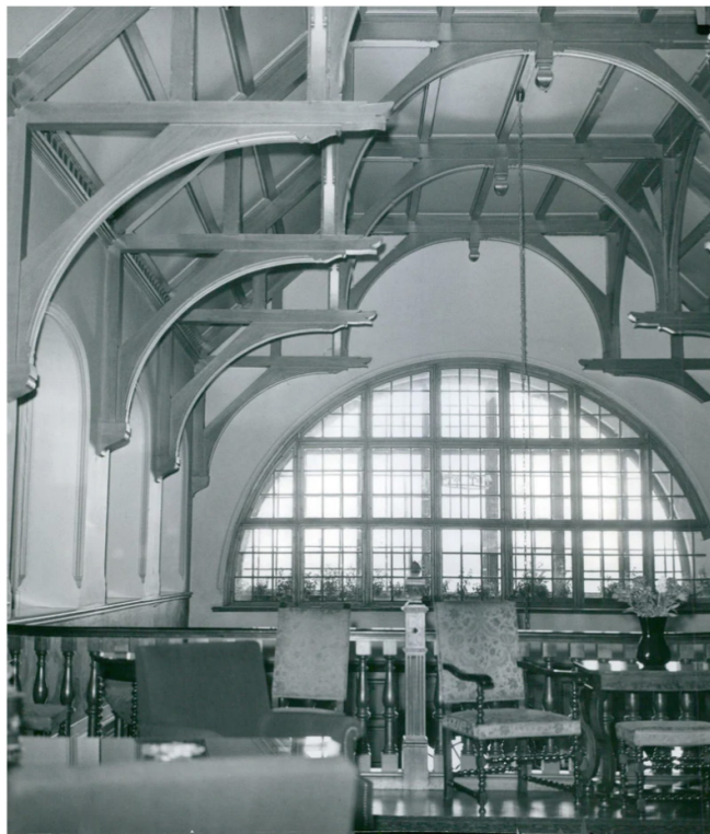
Övre delen av lobbyn mot söder innan bjälklaget tillkom. Foto Gunnar Latz åt Svenska Dagbladet 1959.
