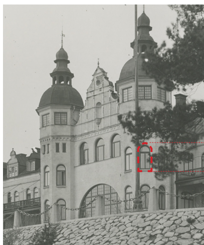
Ursprungligt utförande, trelufts korspost, välvd övre luft.
