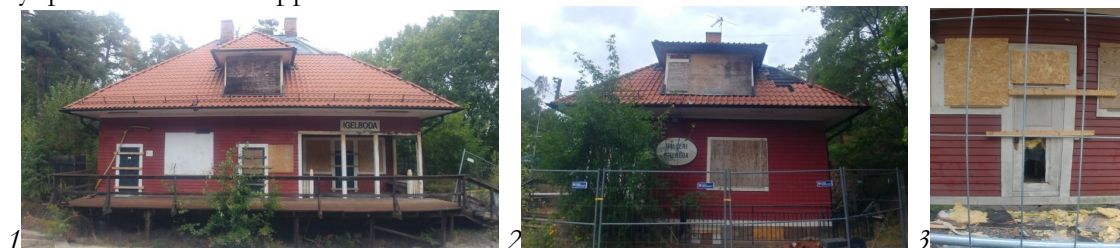
Bild 1-3 är tagna vid bygglovenhetens tillsynsbesök den 31 augusti 2020.
