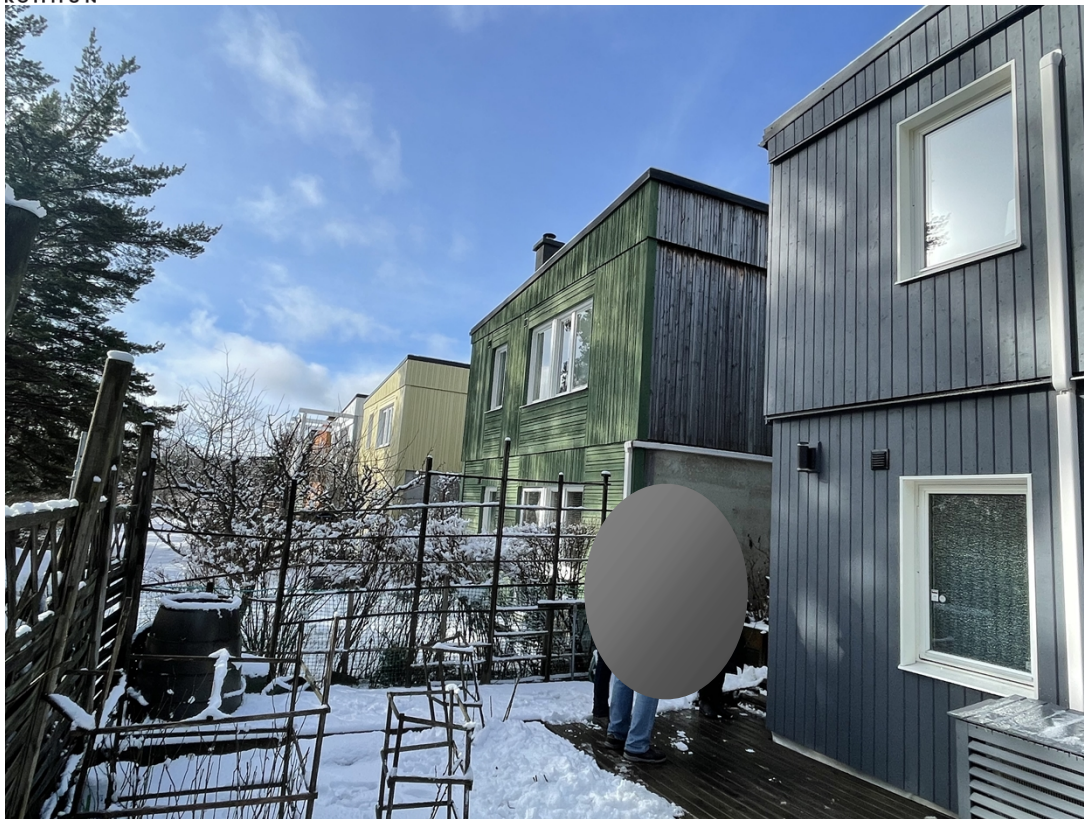
Bild 11. Fasaden sett i sammanhang med intilliggande fastigheter.
