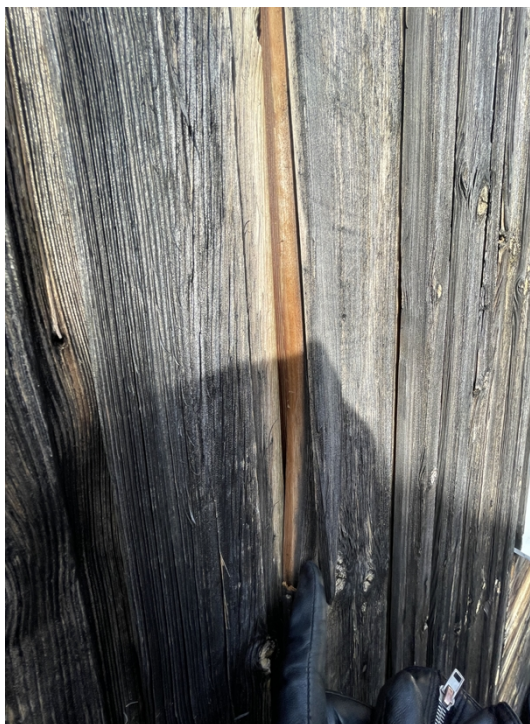
T.v. Bild 4. Närbild på sprucken panel på fasad på innergården (åt norr bredvid passage till fastighetens framsida).
