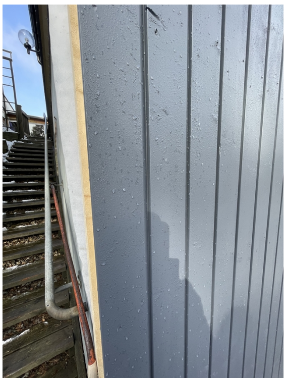
Bild 9-10. Närbild på fasad som bytts ut och isolerats.
