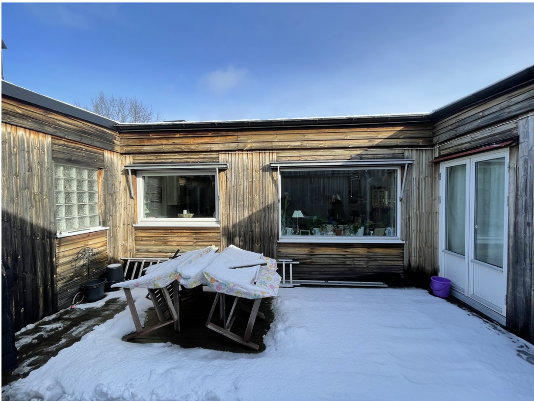
Bild 2. Innergårdens fasader, omålad och oförändrad men avsedd att ändras pga. dåligt skick.
