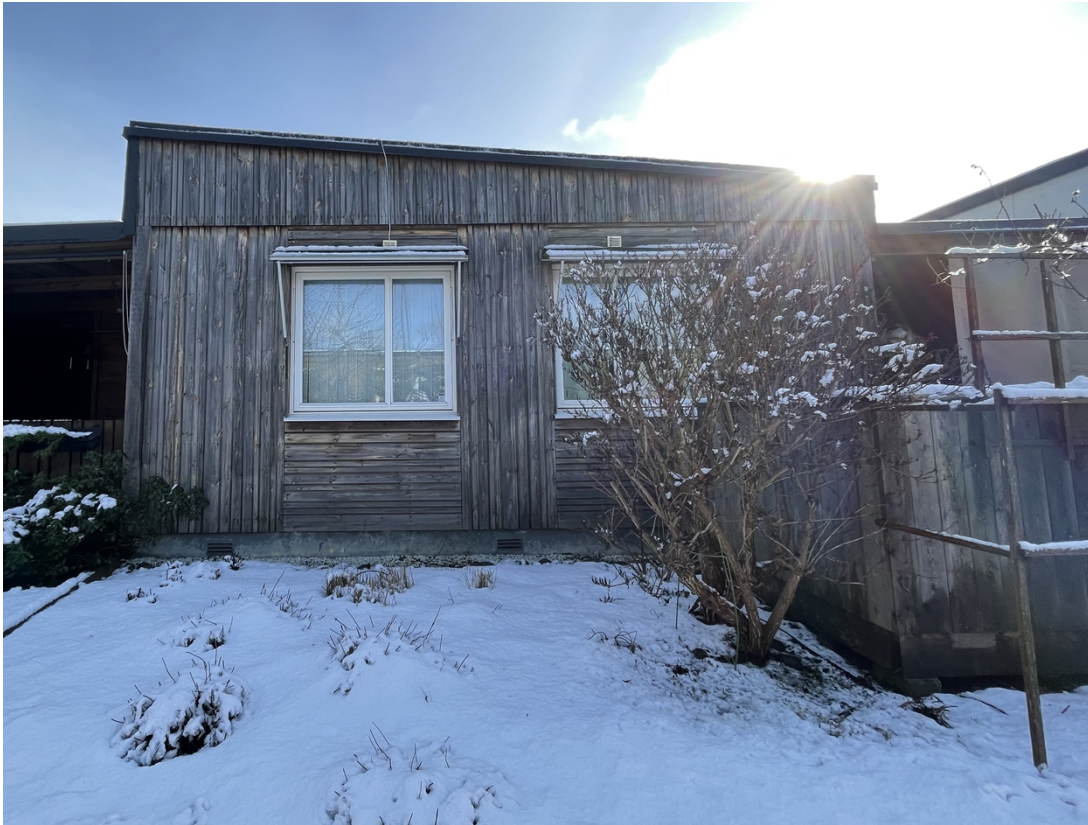
Bild 1. Entréfasad med ursprunglig panel mot gata som inte avses ändras.
