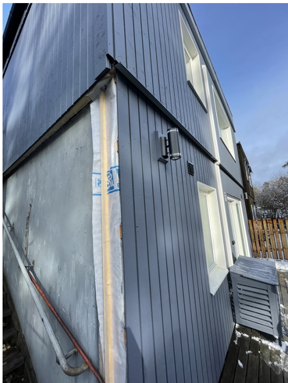
T.v. Bild 7. Fasaden har vid byte isolerats.
