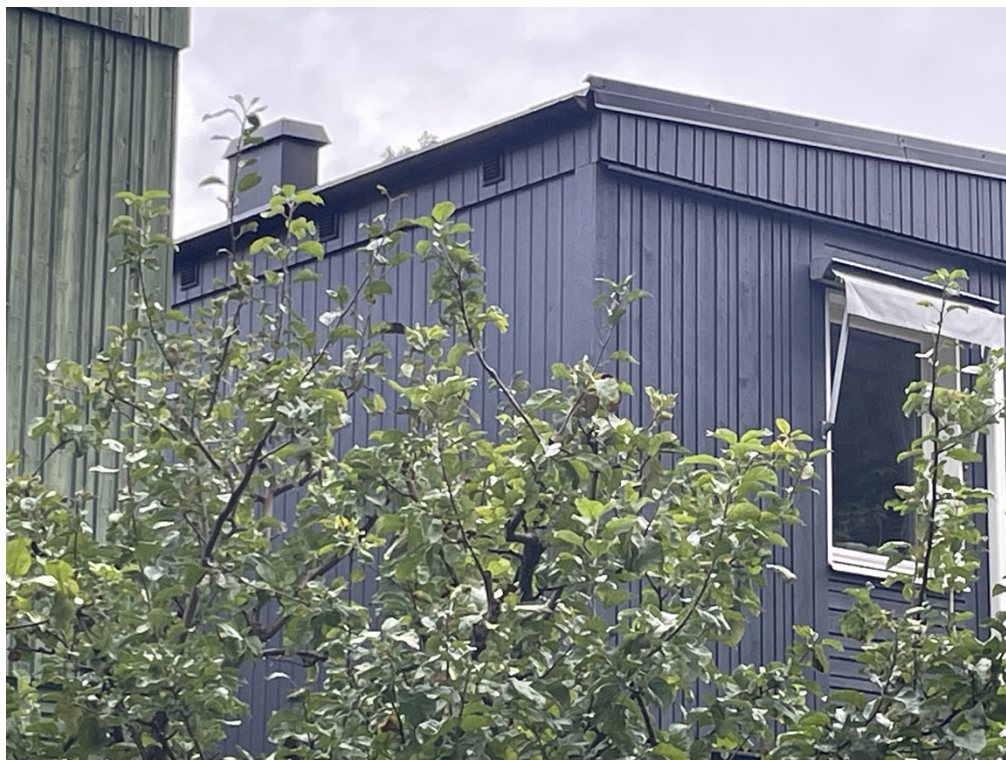
Bild 3. Fastighetens fasad mellan husen i mitten av bilden.
