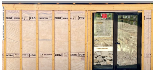
Foto från sökanden att byggnaden är under uppförande, inkom den 15 juni 2023
