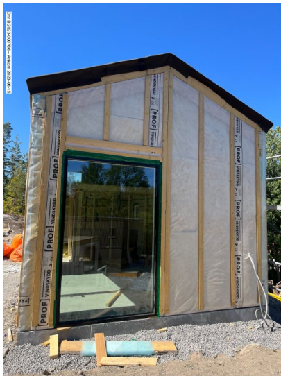
Foto från sökanden att byggnaden är under uppförande, inkom den 15 juni 2023.
