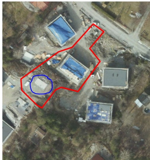
Flygfoto från 7 maj 2023 som visar att byggnation är påbörjad, grunden för komplementbostadshuset är inringad i blått.
