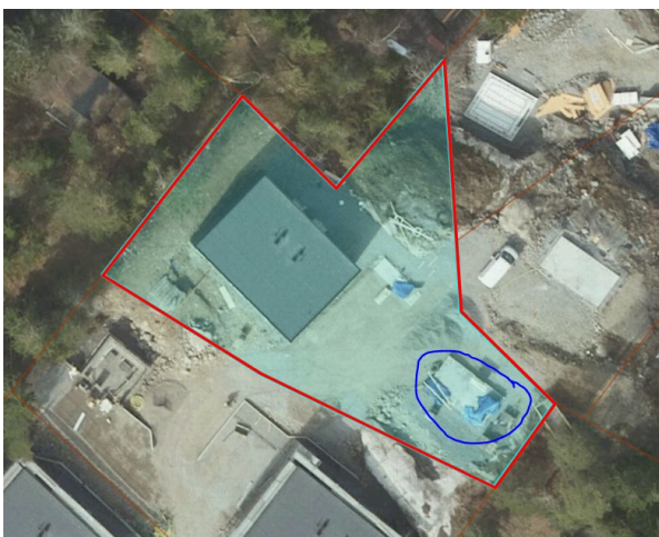
Flygfoto från 7 maj 2023 som visar att byggnation är, påbörjad komplementbostadshuset är inringat i blått.
