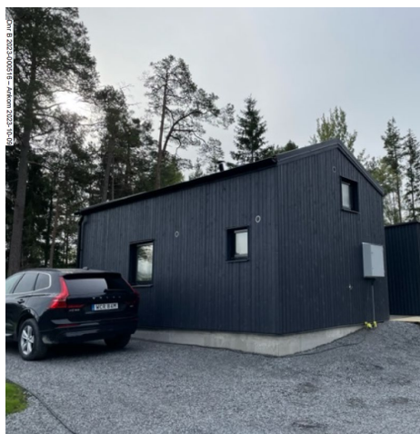
Foto från sökanden att byggnaden är uppförd inkom den 9 oktober 2023.
