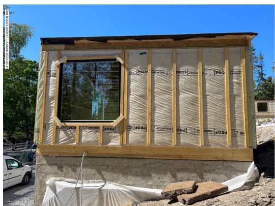
Foto från sökanden att byggnaden är under uppförande, inkom den 15 juni 2023.
