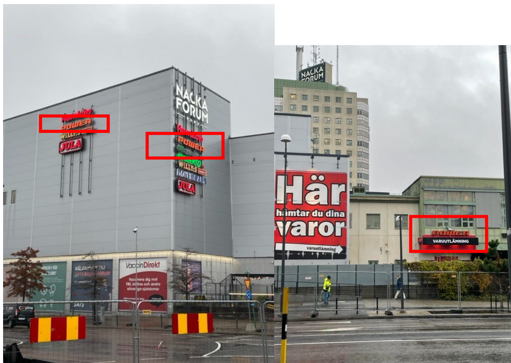
Bilder tagna vid platsbesök den 9 november 2023. Bild till vänster visar skyltstorlek 2. Bild till höger visar skyltstorlek 1 och 3.
