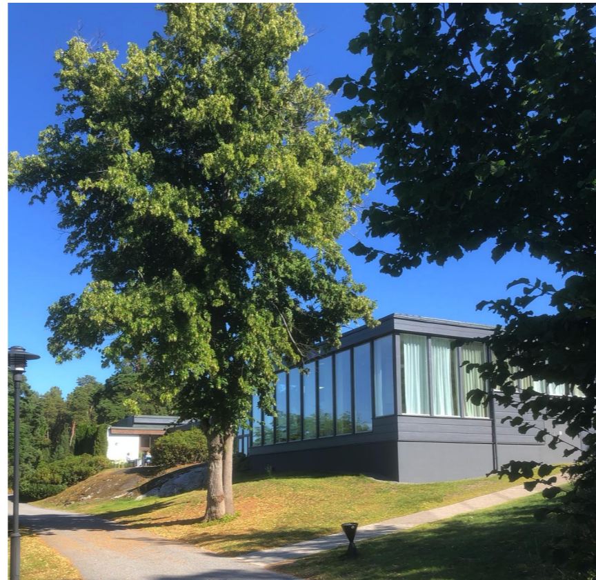
Den nya restaurangtillbyggnaden med glaspartier från golv till tak
