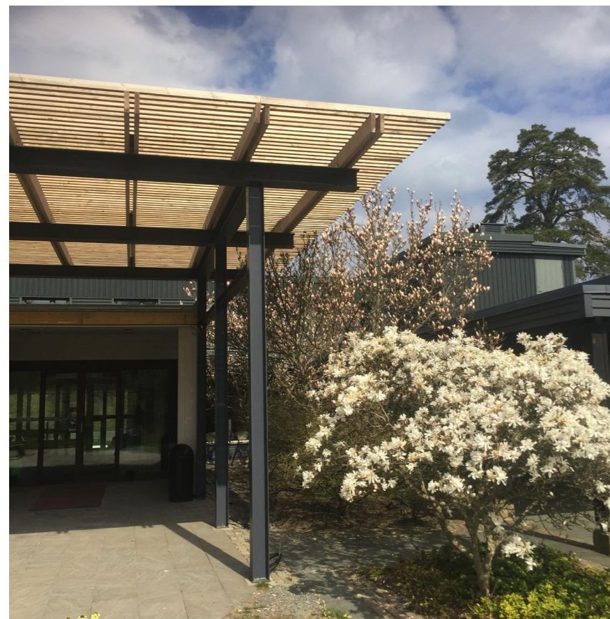
Exempel på senare tillägg. Pergolatak vid huvudentrén. Stål, kiselbehandlat trä och glas i en transparent konstruktion
