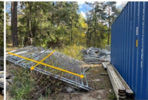
Byggstaket uppmättes ligga placerade på en yta om 4,2x3,8 meter, se orangea pilar.
