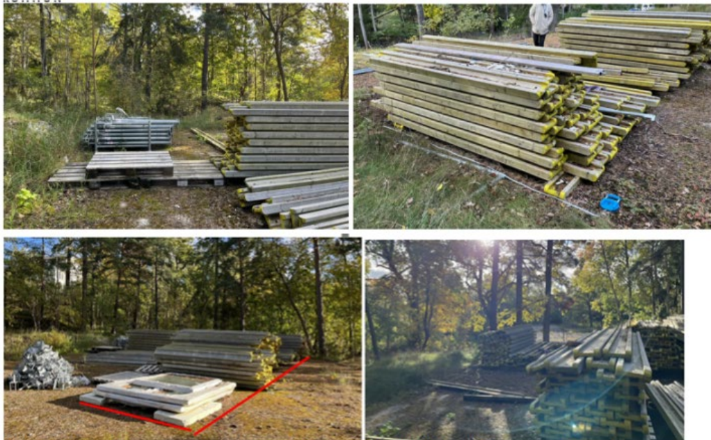
Delar av byggställning samt övrigt byggmaterial uppmättes till 10,2x3,5 meter, se röd markering.
