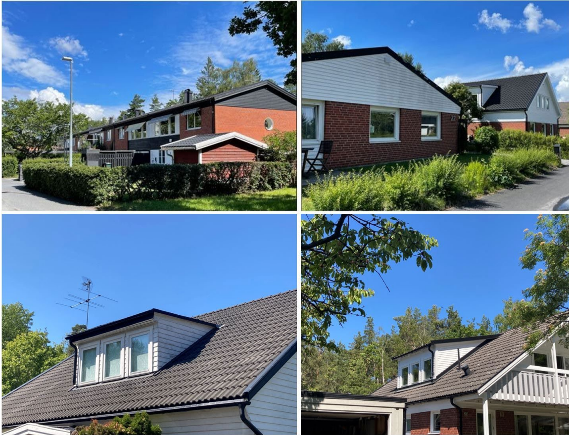
Figur 4. Övre raden från vänster till höger: Befintliga radhus, ursprunglig enplansvilla och påbyggd villa med inredd vind och takkupa. Nedre raden: Typisk utformning av takkupa i området. Foto: Nacka kommun (2022, 2023)
