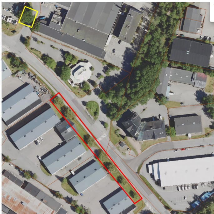
Figur 5: Befintlig allé längs del av Skarpövägens södra sida inom rött område. Ek på allmän platsmark inom gult område.
