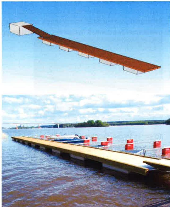
**Landgång:** 1,5 x 4,0 meter i impregnerat trä, NTR A. Landgången fästs i landfästet med vertikala beslag. Landgången vilar på bryggan på en rostfri, syrafast slitplåt, 1,0 x 2,0 m.
