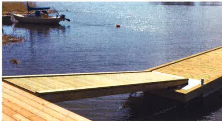
**Förankring:** Träbetongbryggan förankras i hörnen med 4 st 1,0 ton betongankare.
