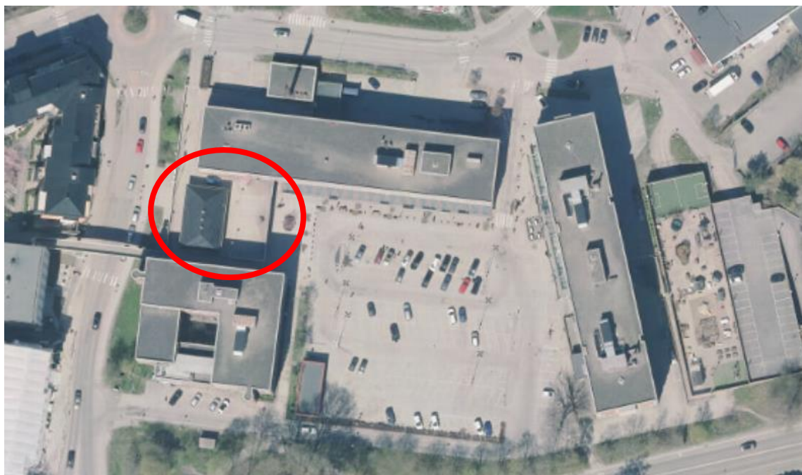
Plats i byggnaden för tidigare ansökan i ärende B 2017-1138, lokalerna finns en våning upp med skolgård på byggnadens östra sida.
