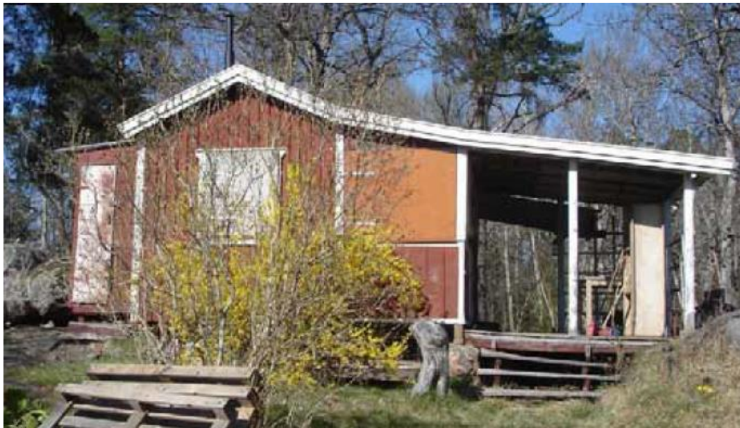
Den nedbrunna stugan
