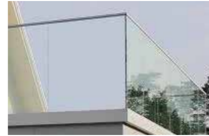
Balkongutformning helt i laminerat säkerhetsglas, klarglas. Inga vertikala stommar och nätt överligger i natureloxerad aluminium. Fabrikat Arqdesign Vision eller likvärdigt.
