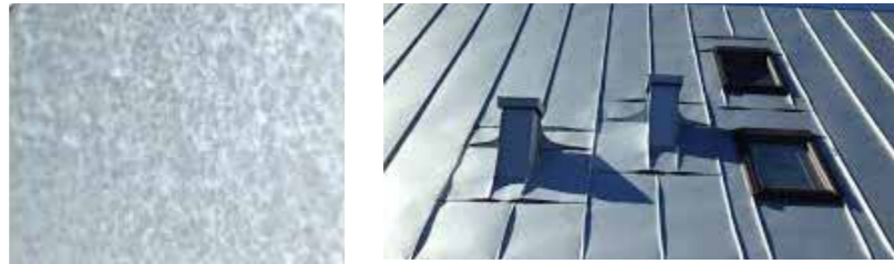
Taktäckning bandtäckning med Aluzink. Takkupor har samma material.
