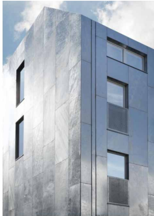
Fasad mot gatan kläs med varmförzinkade stålplattor ca 3 mm tjocka. Indelning av plattor lika bild till höger.
