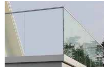
Balkongutformning helt i laminerat säkerhetsglas, helt genomskinligt. Inga vertikala sommar och nätt överliggare i natureloxerad aluminium. Fabrikat Arqdesign Vision eller likvärdigt.
