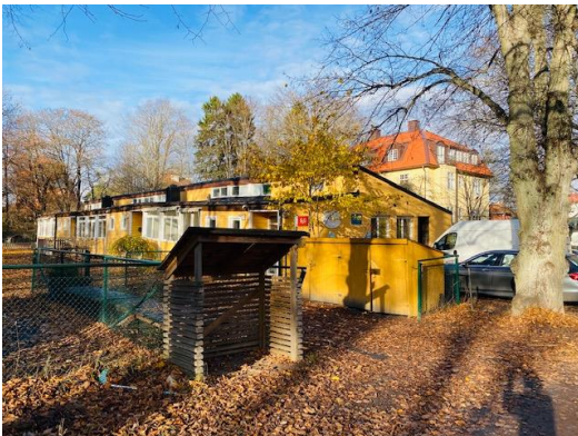
Bilden är tagen från Ringvägen och visar hus för sopkärl och angöring för lastning.
