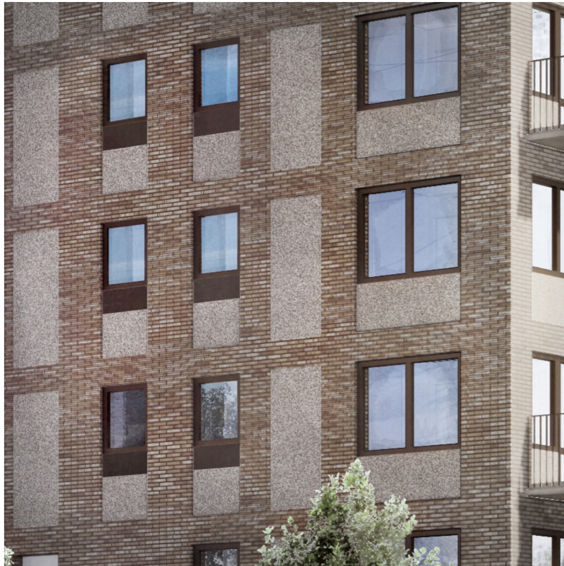
Princip - fasadens gridsystem med ramverk av tegel, intryck med puts och plåtavtäckningar vid fönster.
