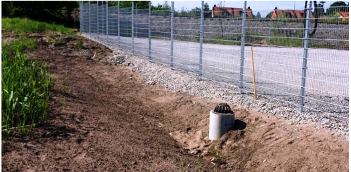
Figur 4. Placering av brunn för att skapa en fördröjningsvolym i regnbädden. Foto: WRS
