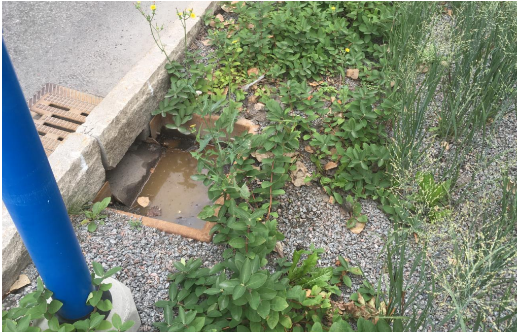
Figur 2. Inlopp till regnbädd genom brunn och erosionsdämpande kar. Exempel från Strandbodkilen i Uppsala, foto WRS.
