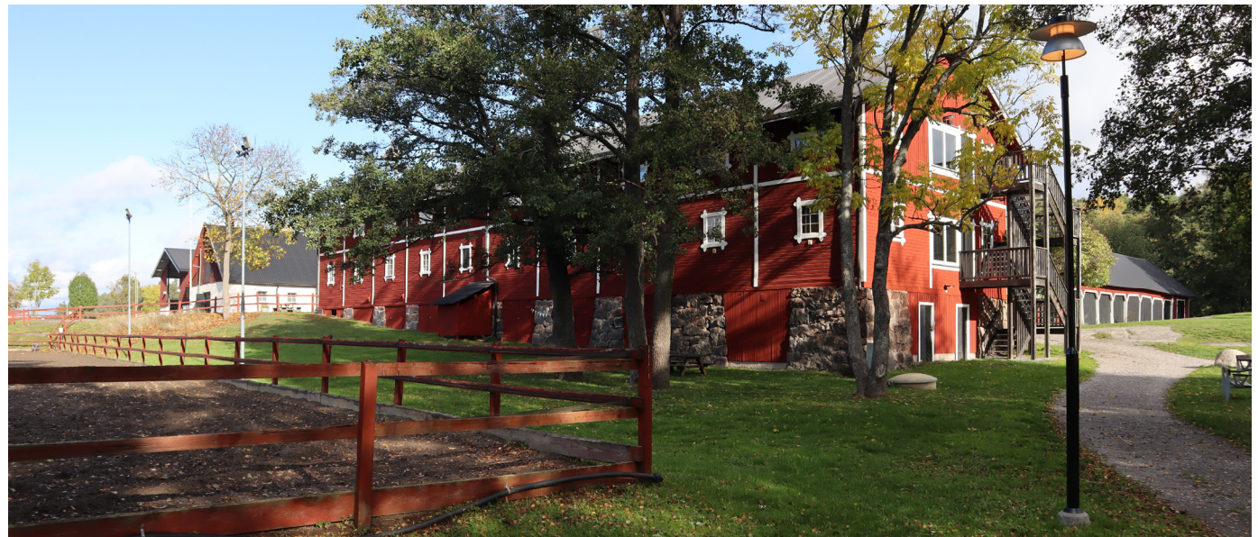
Magasinbyggnaden har ett respektfullt möte med den sluttande marken, där landskapets former råder.
