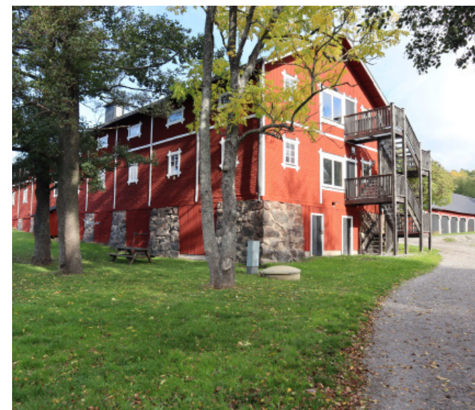
Magasinsbyggnaden på hög naturstenssockel.
