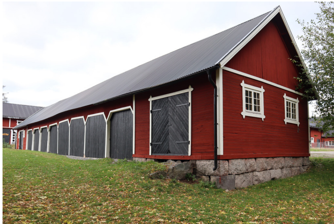
Vagnslidret tar upp höjdskillnaden i terrängen genom en huggen naturstenssockel.
