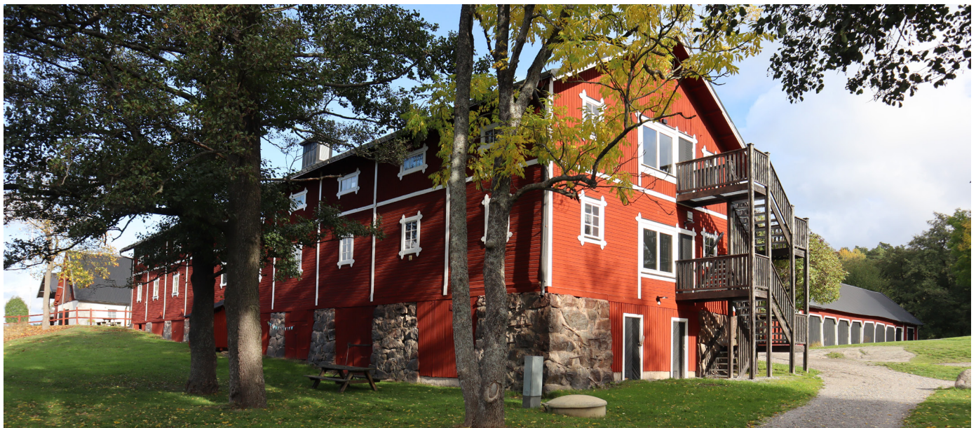
Magasinsbyggnaden tar upp markens höjdskillnad genom naturstensplintar (obs att mellanliggande inklädnad av grunden är tillkommen i sen tid).
