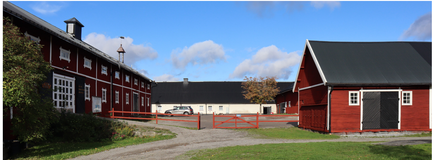
Den södra uddens kulle möter ett väldefinierat gårdsrum med ett planterat gårdsträd. Magasinbyggnaden är den dominerande byggnaden inom planstrukturen, både p.g.a. dess höjd och dess placering.
