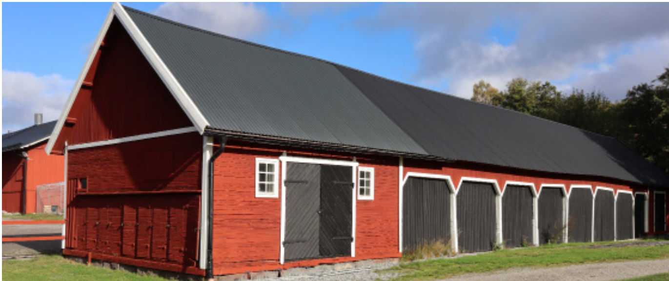
Vagns- och redskapslider med rödfärgade fasader och vitmålade lister och fönster på huggen naturstenssockel i souterrain.
