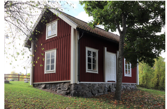
Holmska stugan med hittad naturstensgrund som tar upp byggnadsplatsens höjdskillnad.
