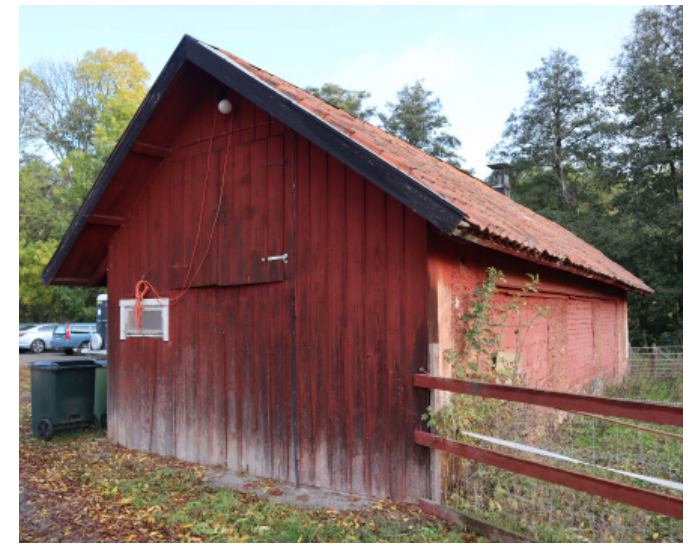
Hönshuset är uppfört med locklistpanelade fasader täckt med enkupigt lertegel.
