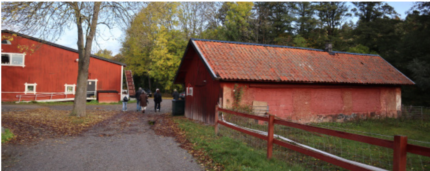
Hönshusets södra sida är murad och putsad med igenmurade tidigare öppningar och stensockel. Södra sidan av hönshuset utgör möjligen en återstående del av det rivna stallet.
