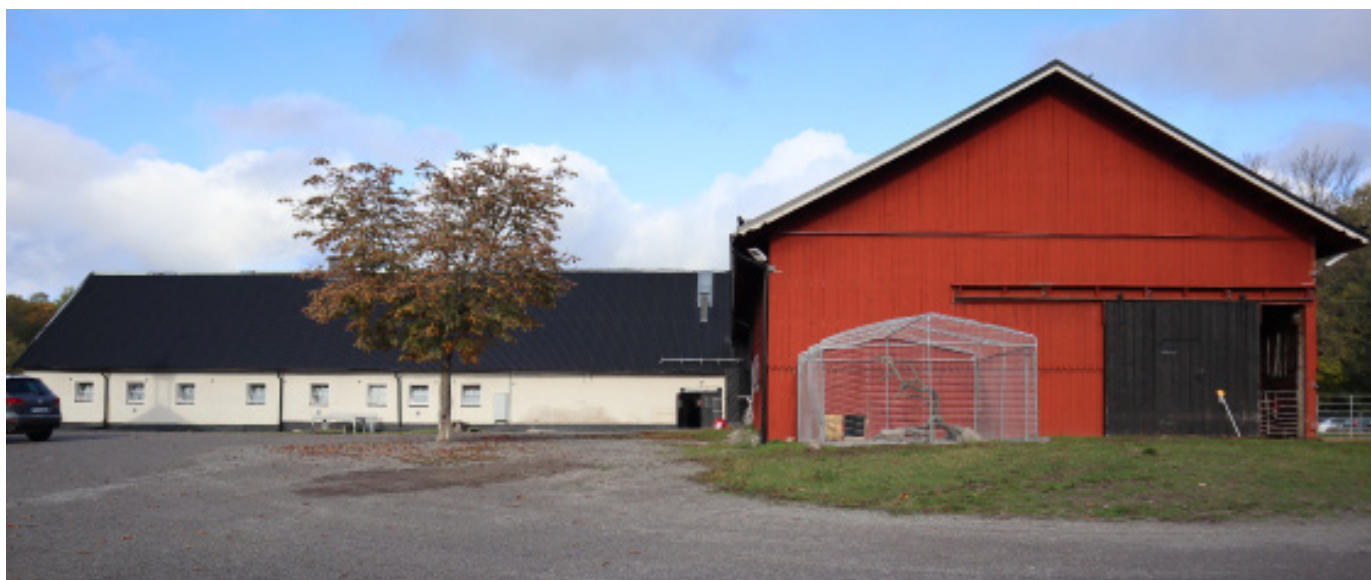
Stallbyggnad med tillbyggd loge.
