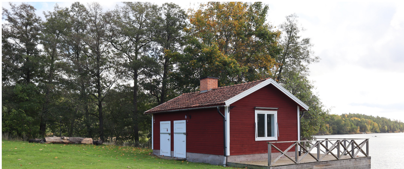
Raststuga uppförd som tvättstuga omkring 1950.
