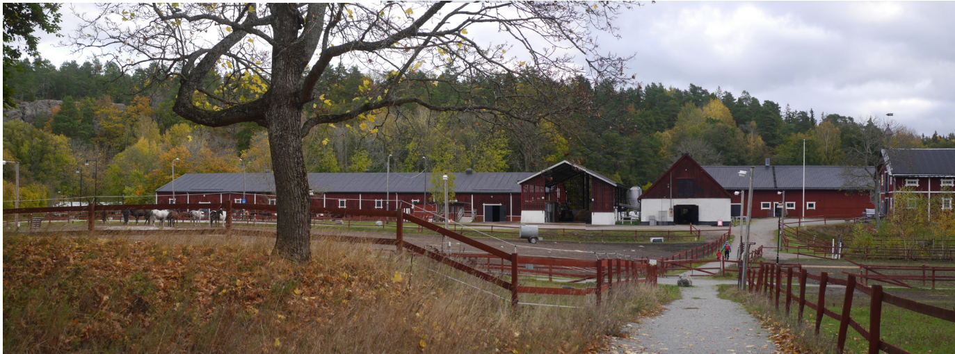
Vy över det öppna landskapsrummet framför stallarna och med det låga, men långa ridhuset till vänster.
