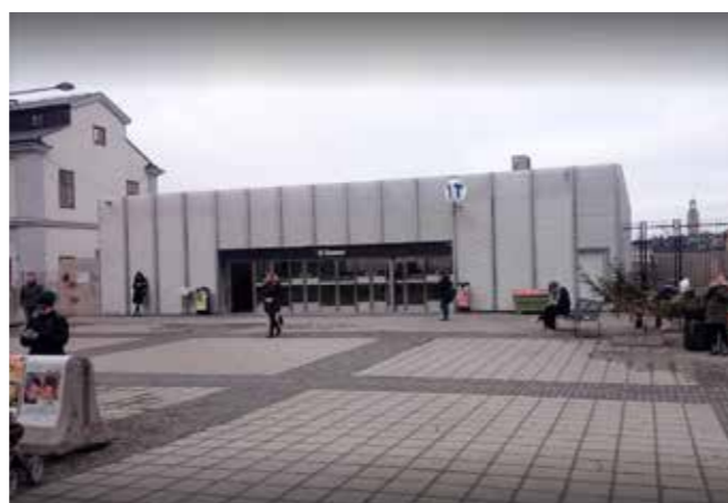
TILLFÄLLIG ENTRÉ TUNNELBANA SLUSSEN STRECKMETALL. DAGSLJUS
