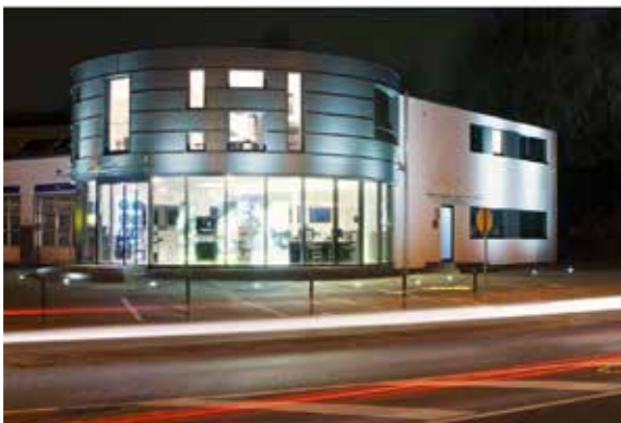
FÖRVALTNINGSBYGGNAD LAUTERBACH TYSKLAND, RHEINZINK
