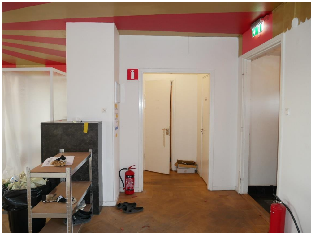
Mitt i bild öppningen till nuvarande kapprum med dörrar mot wc och badrum från 1953. Dessa delar föreslås att rivas och ersättas med trappa och hiss. Foto AIX 2019.
