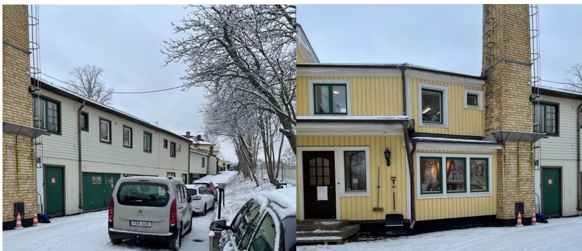
Del av befintlig byggnad som skall ersättas.
