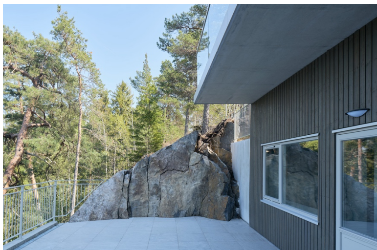
Bild 2. Norra fasaden på Kummelnäs 1:167. På bilden syns hur marken har bearbetats för att möjliggöra byggnadens utformning.
