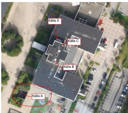
Figur 5. Vy över Ormingehuset med identifierade yttre bullerkällor.
