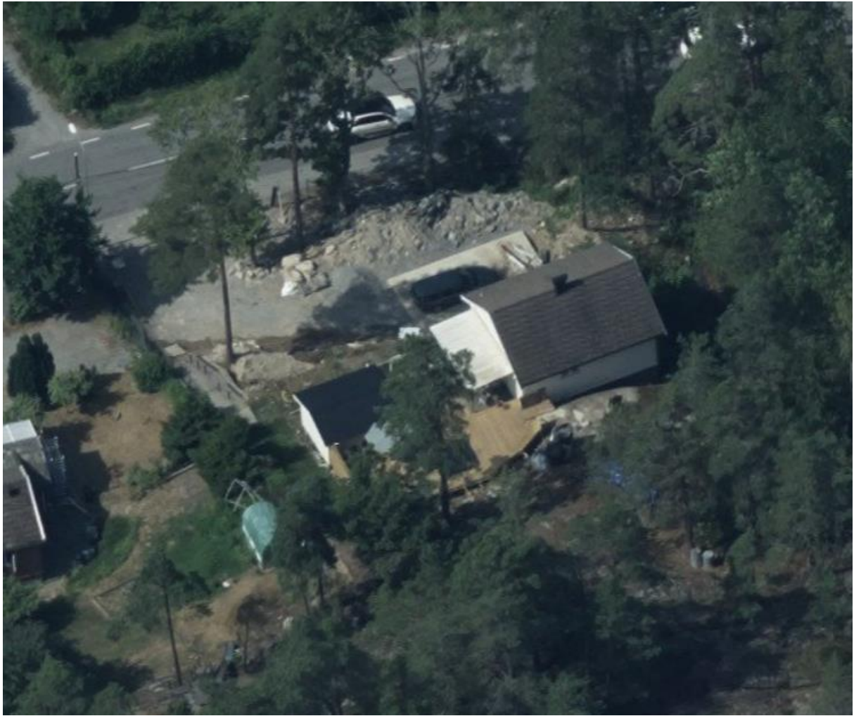
Snedbild från år 2021. Arbetena med markjusteringar och biluppställningsplats har påbörjats.
