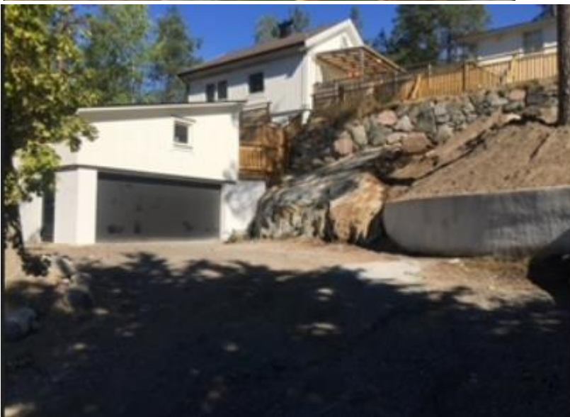
Fotografier på uppfört garage med biluppställningsplats. Ovanför syns befintligt bostadshus med uteplats.
