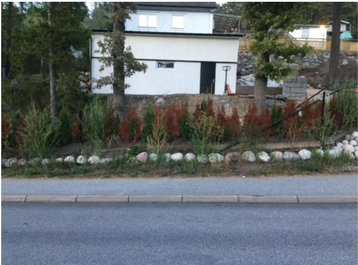
Foto taget från Gustavsviksvägen på uppfört garage.
