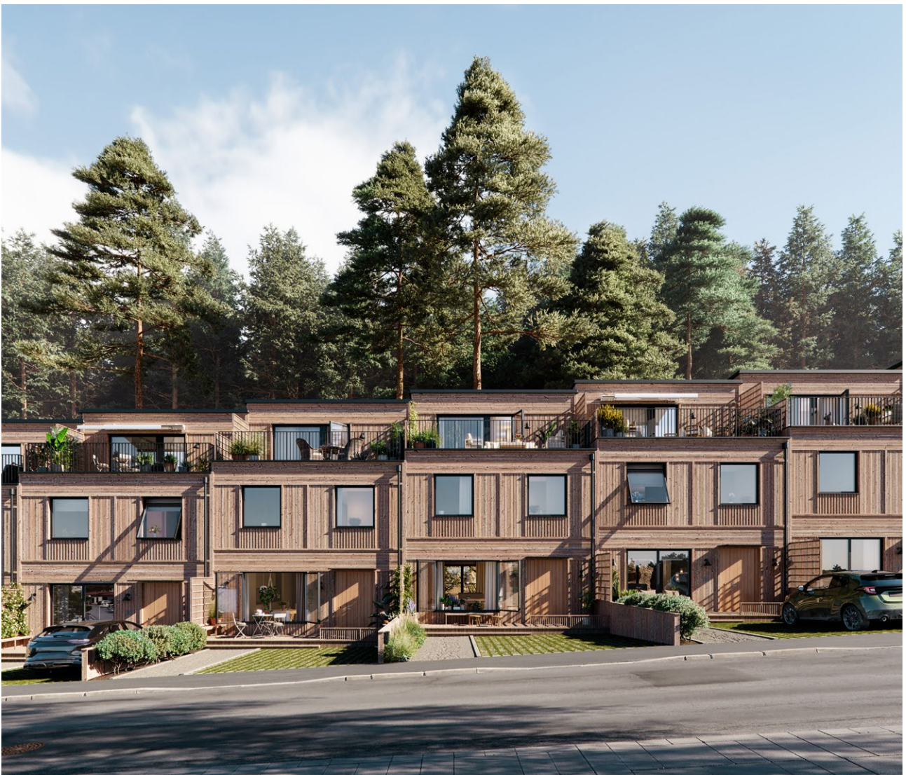
Träfasad behandlad med järnvitrol
