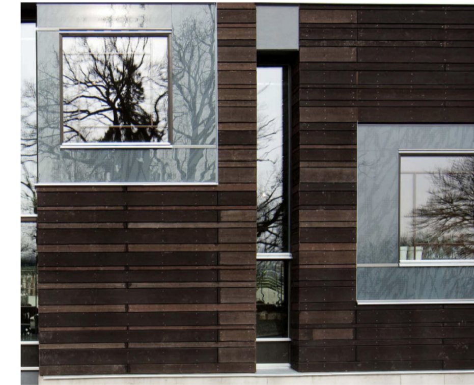
Träpanelen ska utföras i kombination av olika bredder, se exempel på utförande ovan.
