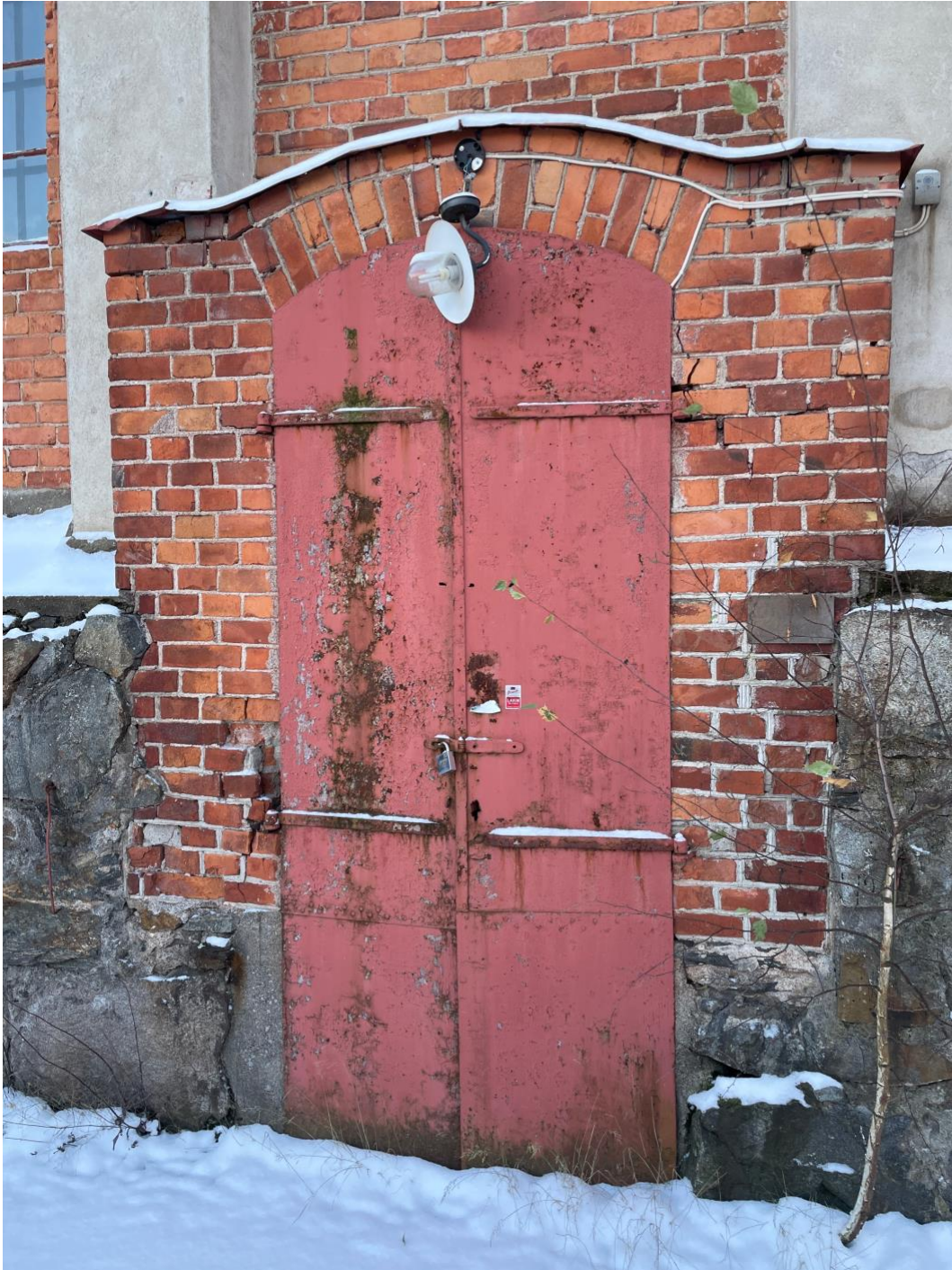
Dörröppning med plåtluckor på stora byggnaden.
