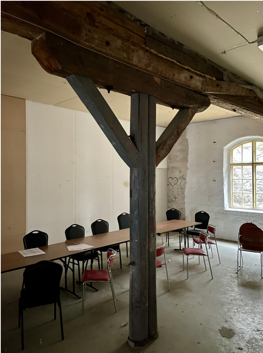
Bilden visar en av totalt tio träpelare/stolpar i den bärande konstruktionen mellan plan två och tre.
