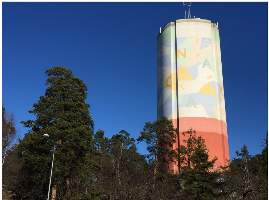
Figur 2 Vattentornet i Jarlaberg
