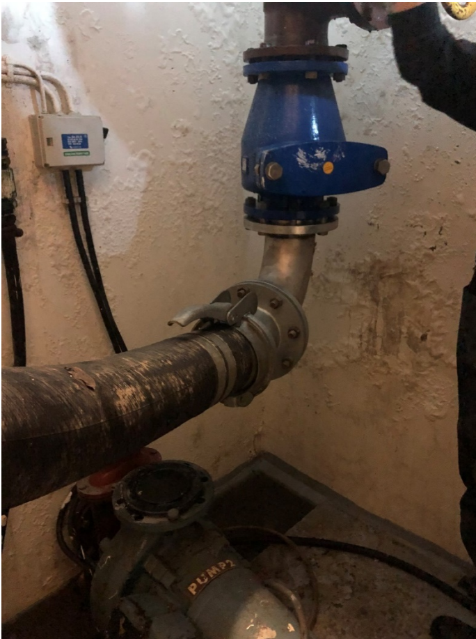
Figur 3 Temporär rörkoppling. SPU 805
